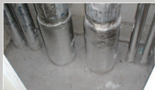
Rebouchage Coupe-feu sur une des 20.000 penetrations.
