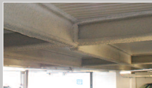
Respect de l’aspect esthétique recherché par l’utilisation de Grace Monokote ® Z-106 sur les zones du parking.
